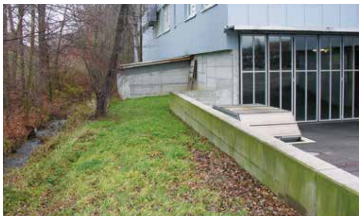
Protezione dalle piene per un deposito di prodotti chimici (Foto: Amt für Umwelt, Ct. TG)
