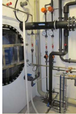
Wärmerückgewinnung für Vorwärmung des Trinkwassers
