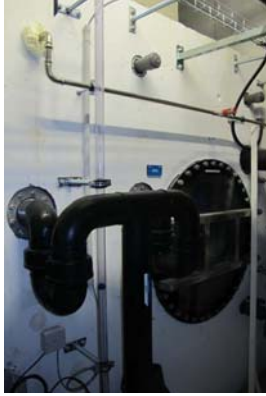
Ausgleichsbecken mit Überlauf direkt in Kanalisation
