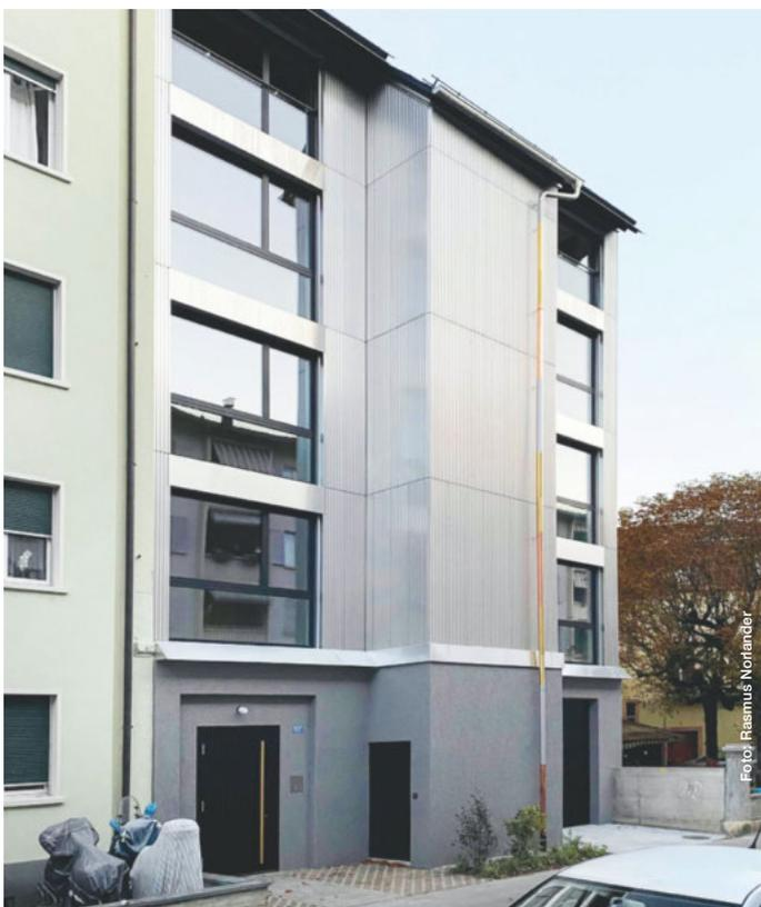
**Strassenfassade der Gebäudeaufstockung. Gut sichtbar: das Fallrohr der Regenrinne, das mit Reststücken aus der Spenglerei gefertigt wurde.**
