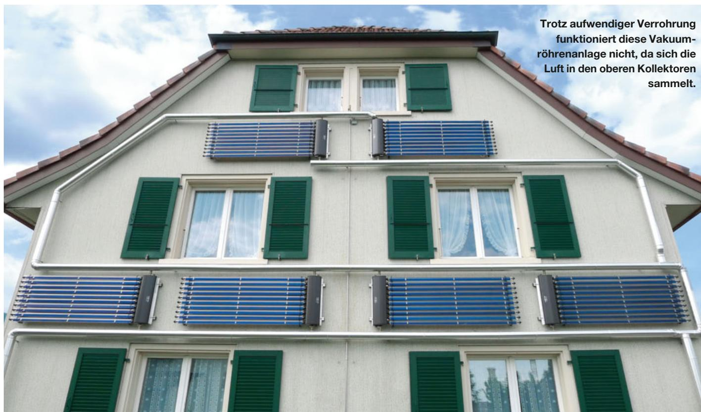
Trotz aufwendiger Verrohrung funktioniert diese Vakuumröhrenanlage nicht, da sich die Luft in den oberen Kollektoren sammelt.
