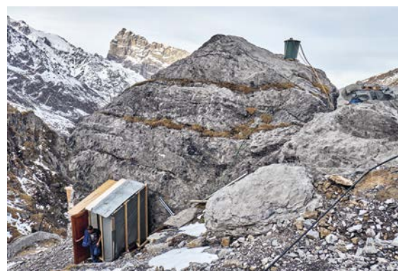
Die Baustellendusche: Im grünen «Boiler» (oben) wird mit einem Tauchsieder Warmwasser erzeugt.
