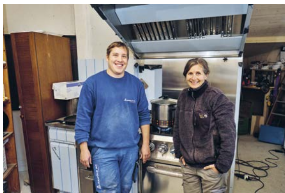
Hüttenwartin Silvia Hurschler Bieri in der neuen Küche. Sanitärinstallateur André Gisler hat für Herd und Ofen den Gasanschluss eingerichtet.
