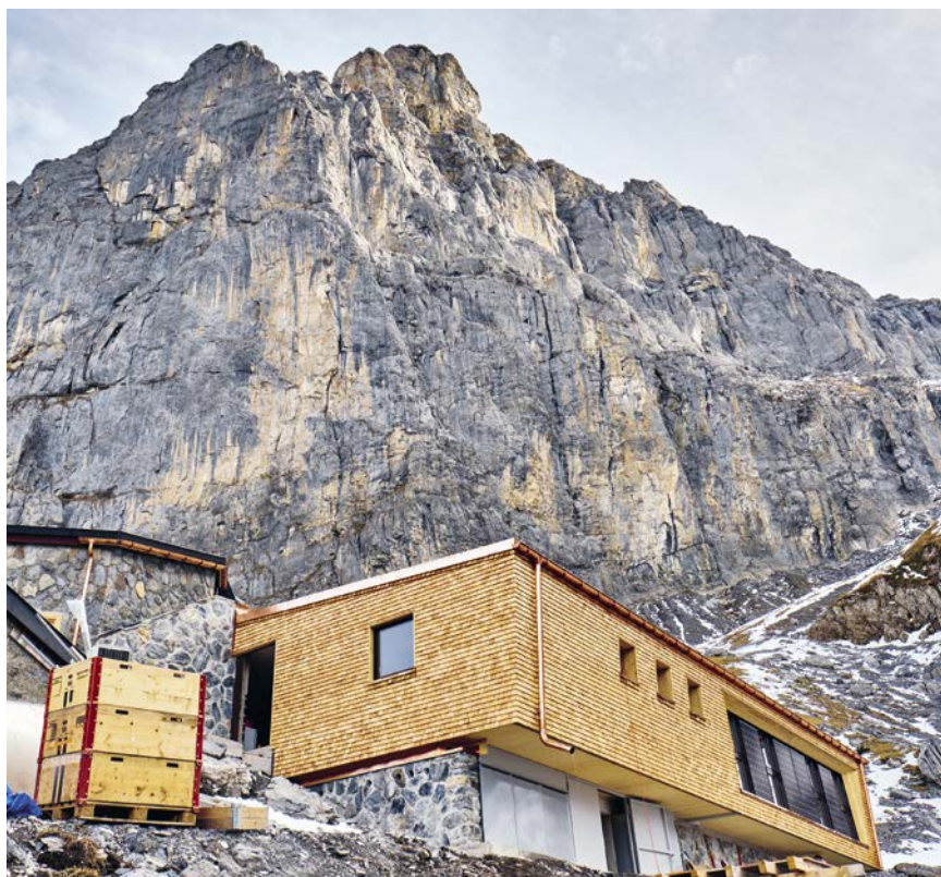
An der Fassade des Neubaus mit Schlaf- und Sanitärräumen erzeugen PV-Kollektoren Strom. Warmwasser wird mit thermischen Kollektoren generiert (oben rechts).
