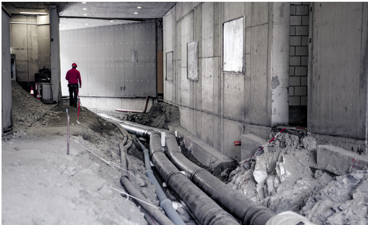
Grâce à ces conduites, l'hôtel The Capra sera bientôt raccordé au réseau de chaleur à distance solaire de Saas-Fee.
