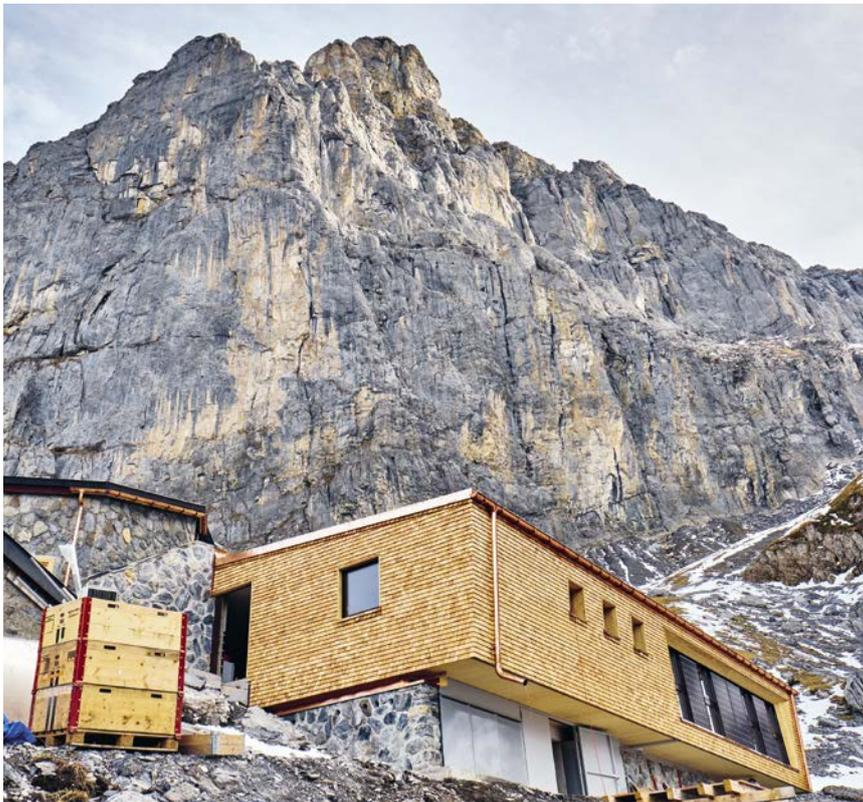
Des capteurs photovoltaïques installés sur la façade du nouveau bâtiment abritant dortoirs et sanitaires fournissent de l'électricité. Des capteurs thermiques (en haut à droite) génèrent quant à eux l'énergie nécessaire à l'eau chaude.
