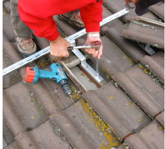
Vorbereitungsarbeiten für Aufdachinstallation
