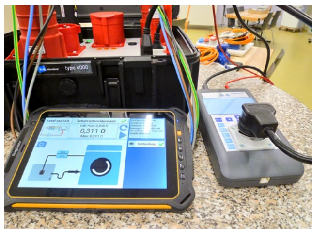
[ABB. 1] Geräteprüfung nach SNR 462638 (Quelle: as-energie GmbH).
