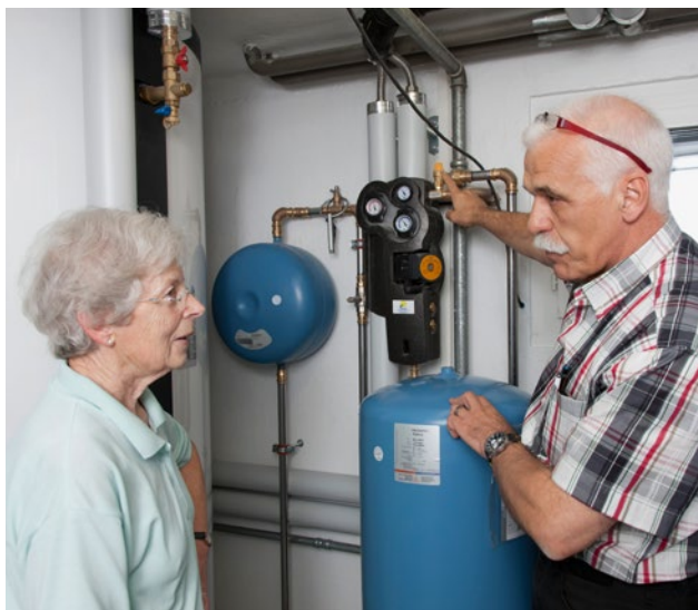
Transmission des instructions au maître de l'ouvrage/à l'exploitant
