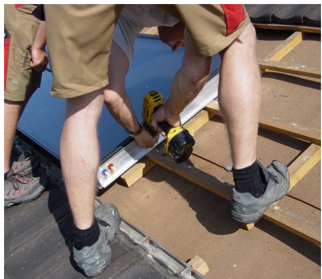
Installation intégrée à la toiture
