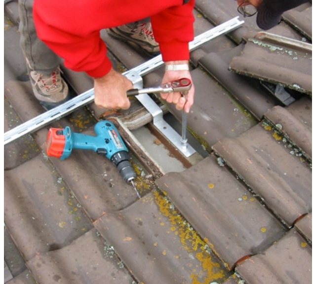
Préparation pour une installation posée sur la toiture
