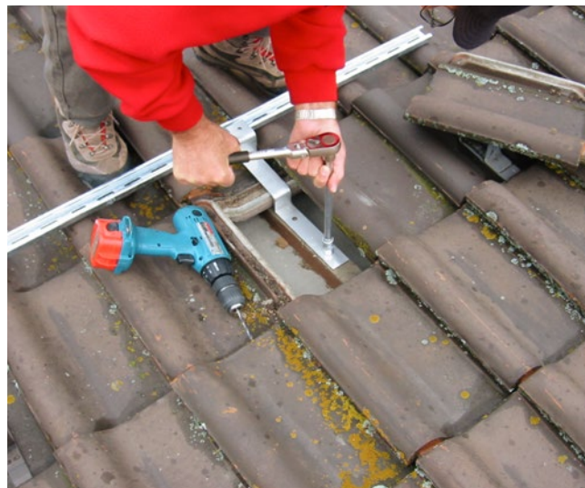
[FIG. 2] Lavori preparatori per un'installazione sopra tetto.
