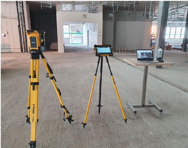
**[FIG. 1]** Apparecchiature in cantiere per il lavoro basato su modelli: tacheometro e notebook di cantiere su un ripiano mobile. (Immagine: Müller Wüst AG).
