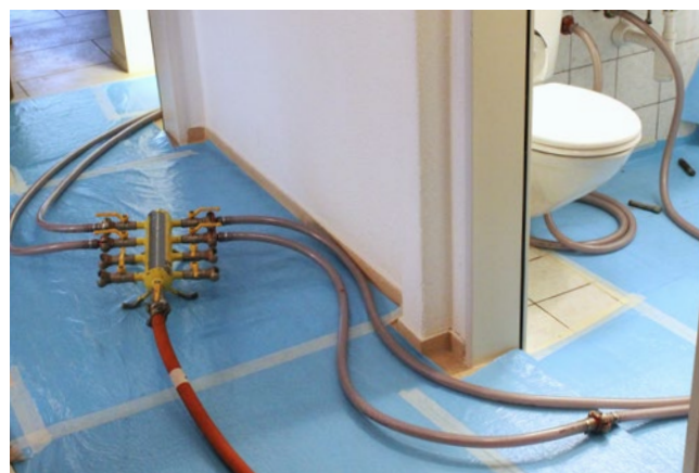
ABB. 1 Ausschnitt einer Rohrinnensanierung in einem Wohnbau.
