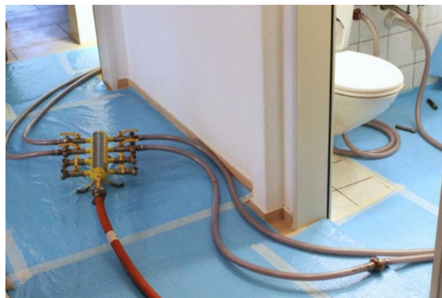
[FIG. 1] Dettaglio del risanamento interno delle condotte in un'abitazione.
