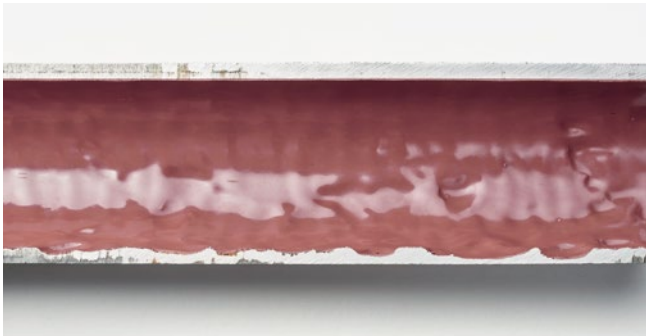
[FIG. 2] Spessore indebolito della parete a causa della corrosione.
