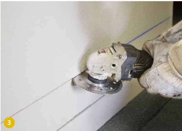
3 Exécuter la rainure et la coupe capillaire au moyen d'outils adaptés.
