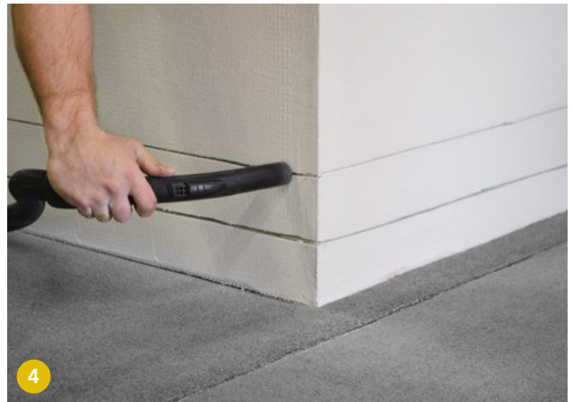
4 Eliminer la poussière de la rainure et de la coupe capillaire (aspirateur, air comprimé, etc.).
