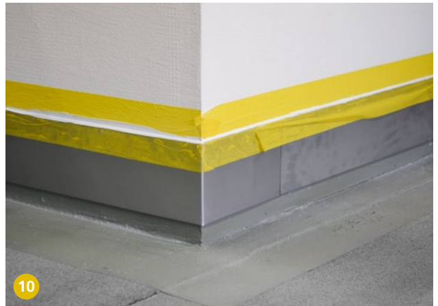
10 Monter la tôle de protection de socle.
