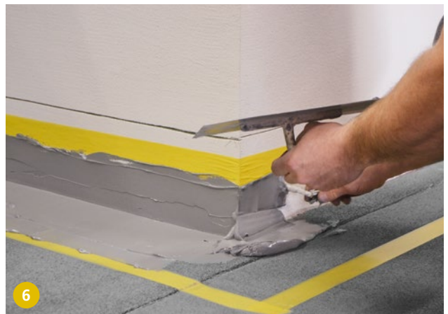
6 En règle générale, le revêtement de protection est réalisé par le façadier et doit être adapté au système de façade.
