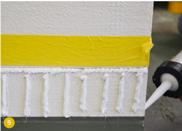
9 Remplir la rainure. Appliquer la colle de montage à la verticale sur la construction pour permettre à l'humidité de s'échapper librement vers le bas et sans causer de dommages.
