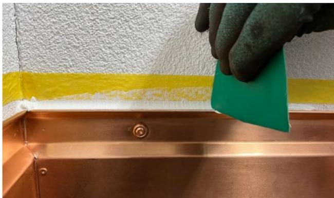
**[FIG. 8]** Le mastic est étalé à l'aide d'une spatule.
