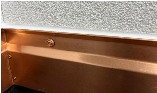
**[FIG. 10]** Le ruban de masquage est retiré et la tôle est nettoyée pour éliminer les éventuels résidus de mastic ou de produit de lissage.
