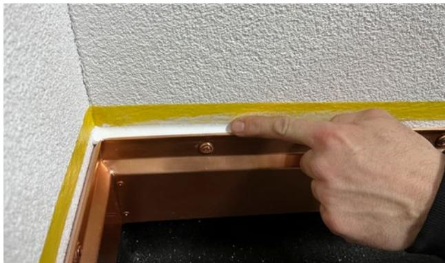
**[FIG. 9]** Le joint est lissé avec le doigt et à l'aide d'un produit de lissage adapté.
