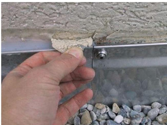
**[FIG. 12]** Exemple d'un joint réalisé de manière inappropriée.
