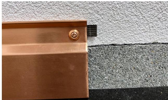
[FIG. 3] La tôle de raccordement à étancher est munie d'une bande de distance et fixée.
