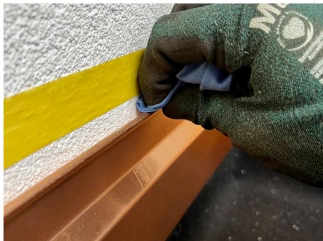
[FIG. 5] Les surfaces adhérentes des parties à jointoyer sont nettoyées avant et après le montage. Celles-ci doivent être exemptes de poussière et de graisse.
