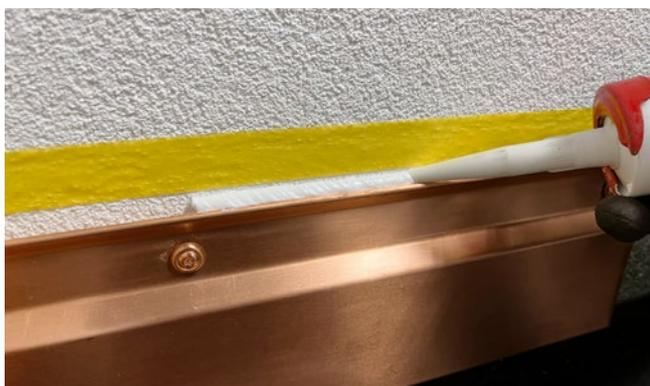
**[FIG. 7]** Le mastic est appliqué en exerçant une pression. Il faut veiller à la bonne taille de la buse (ni trop petite, ni trop grande), à la quantité de remplissage et à l'inclinaison du joint.
