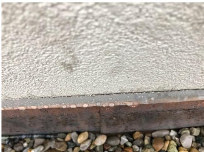
**[FIG. 13]** Joint en mastic qui s'est détaché au fil des ans. Il doit être remplacé au plus vite.
