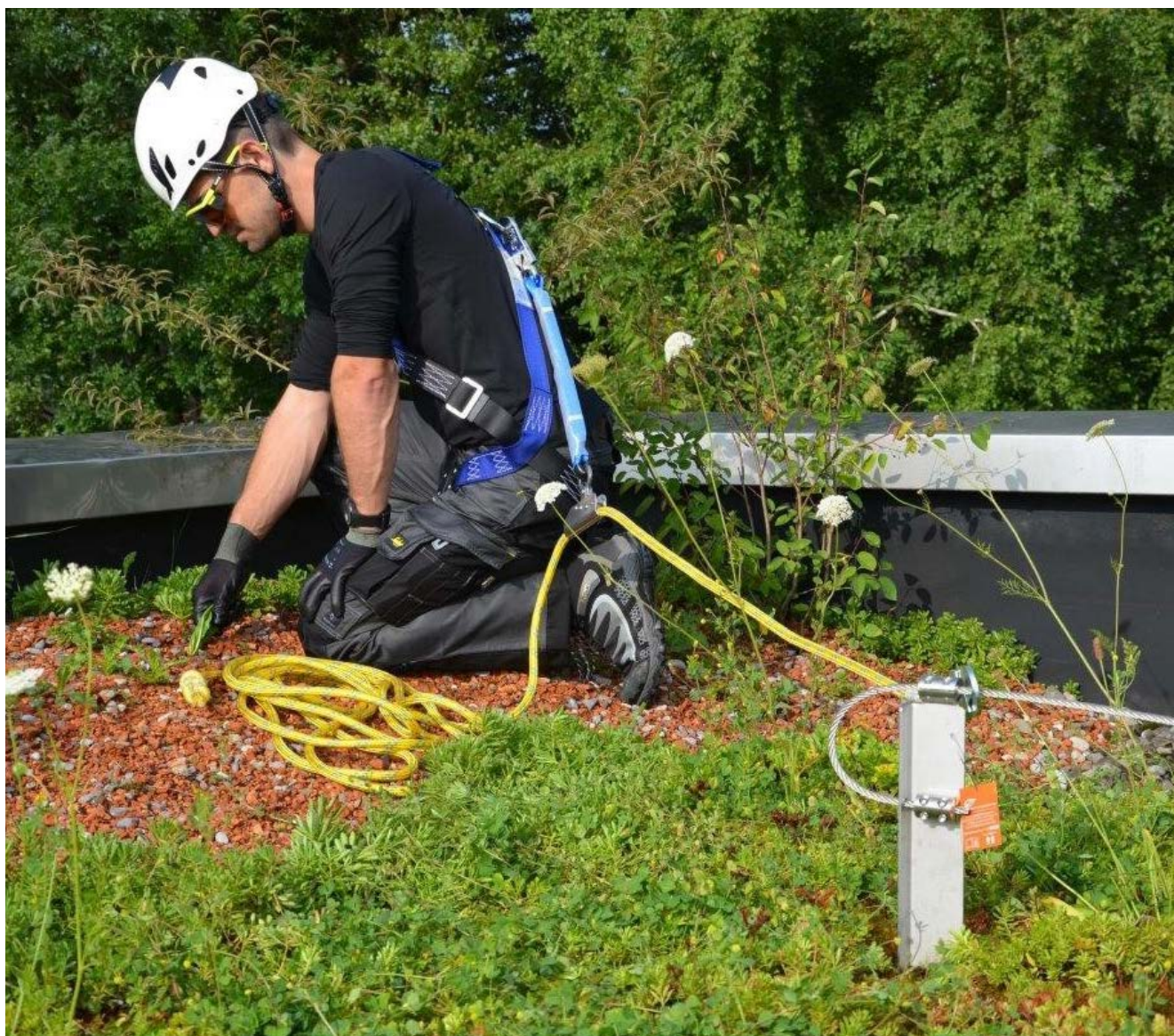
Figure 20: Protection au travail et individuelle lors de l'entretien de la végétation et la maintenance des installations solaires, source: Contec
