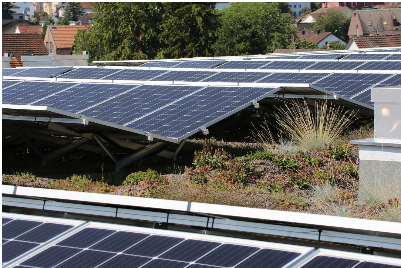
Figure 16: Installation PV orientée à l'est/ouest avec une structure de substrat modelée de hauteur différente, source: Zinco
