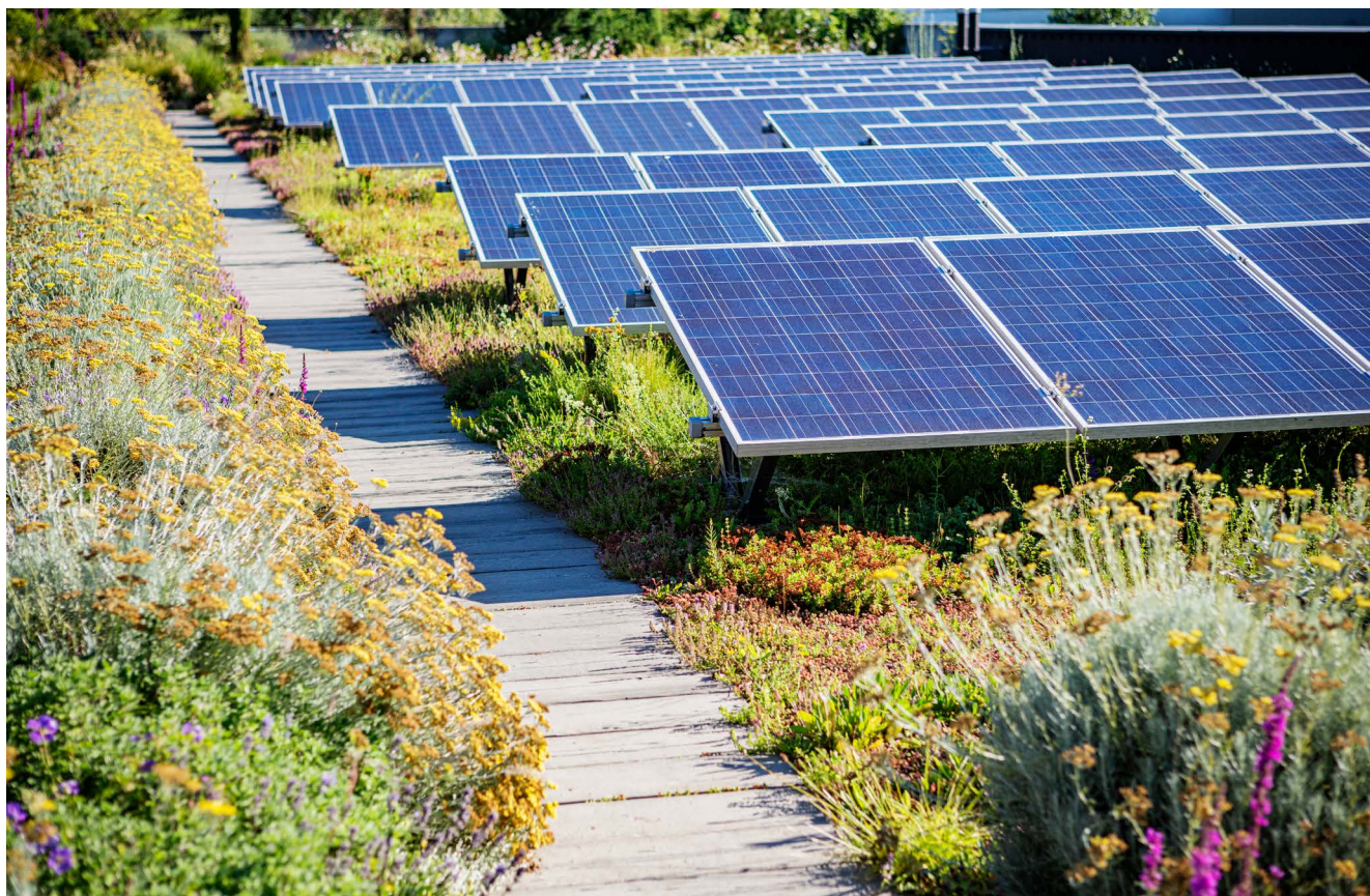
Figure 3: Combinaison d'une végétalisation intensive/extensive de la toiture à côté d'une installation PV, source: Contec
