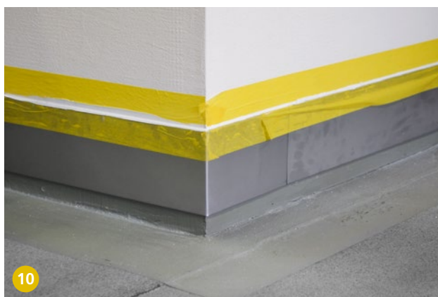
10 Montaggio della lamiera di protezione per lo zoccolo.
