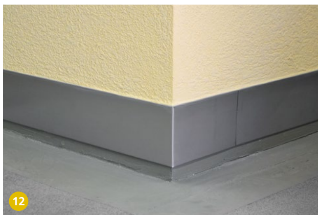
12 Applicare l'intonaco di copertura e la vernice.
