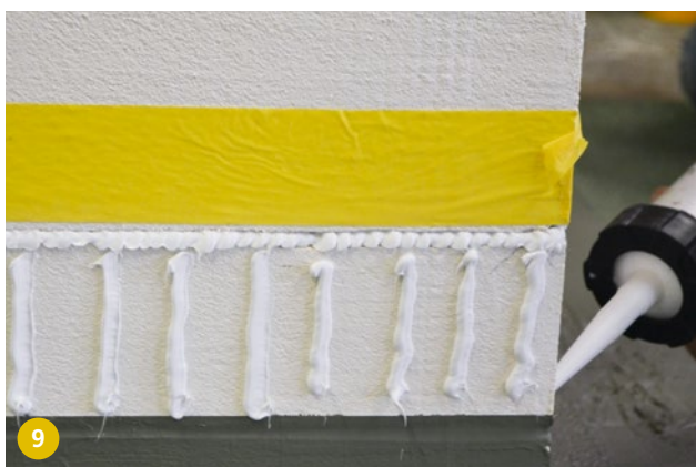
9 Riempimento a ridosso della scanalatura a innesto. Applicazione verticale della colla di montaggio all'edificio; l'umidità che ne deriva può così essere convogliata verso il basso senza impedimenti e senza causare danni.
