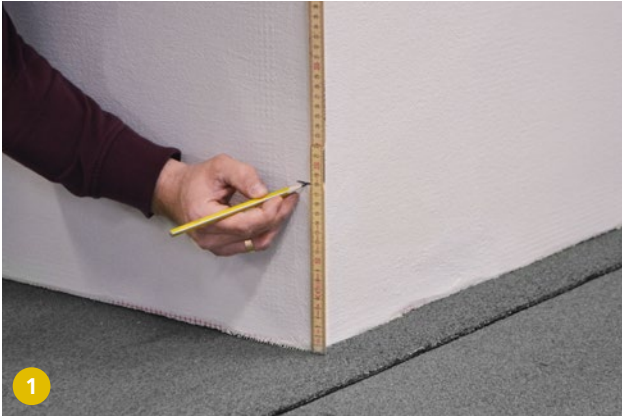
1 Tracciamento della scanalatura a innesto e altezza del taglio capillare.
