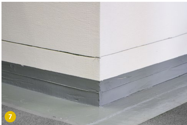
7 Dopo l'avvenuto indurimento della vernice di protezione adattare la lamiera di protezione all'edificio.
