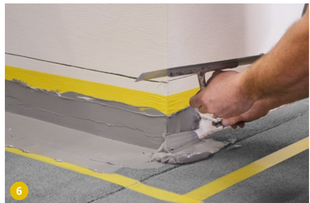
6 Il rivestimento protettivo è solitamente realizzato dal costruttore di facciate e va adeguato in funzione del sistema di facciata.
