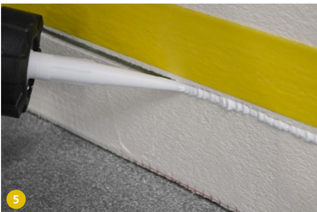
5 Riempire/sigillare il taglio capillare con un materiale elastico e resistente all'umidità. Può essere composto dello stesso materiale come il rivestimento protettivo.
