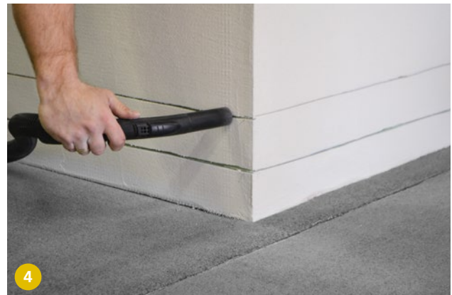
4 Dopo la loro esecuzione, la scanalatura a innesto e il taglio capillare devono essere mantenuti senza polvere (p. es. eliminare la polvere con aria compressa o con l'aspirapolvere).
