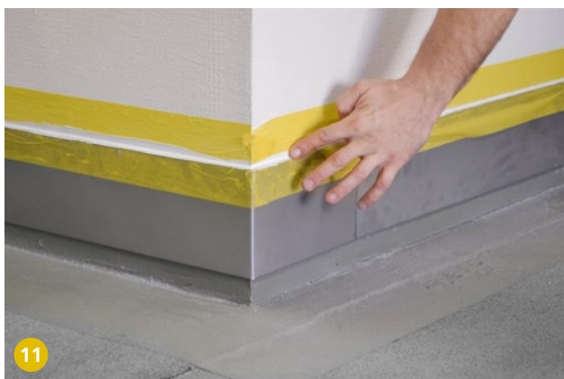
11 Livellamento e asportazione del materiale di riempimento eccedente (non creare un giunto supplementare).
