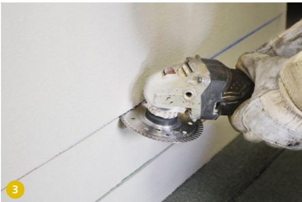
3 Eseguire la scanalatura a innesto e il taglio capillare con mezzi ausiliari adatti.
