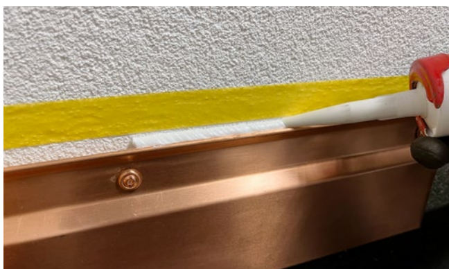
[FIG. 7] Il sigillante viene applicato a pressione. Bisogna verificare che il beccuccio abbia la giusta apertura (non tagliato né troppo in punta né troppo indietro), che la quantità di materiale sia corretta e che il bordo del giunto abbia la necessaria inclinazione.
