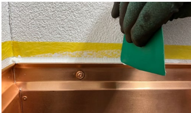
[FIG. 8] Il sigillante in eccesso viene livellato con una spatola.
