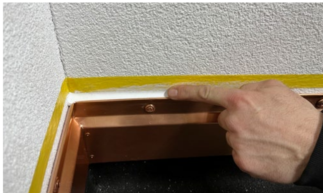
[FIG. 9] Il giunto viene liscio con un dito e con un prodotto lisciante idoneo.
