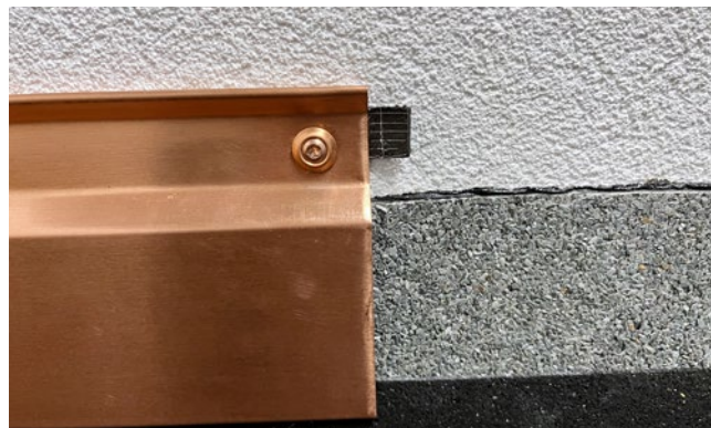
[FIG. 3] La lamiera di raccordo da impermeabilizzare viene fissata dopo aver applicato un nastro di separazione.
