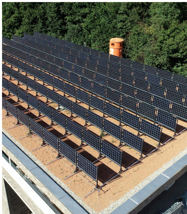
Figura 4: l'impianto fotovoltaico deve essere installato a sufficiente distanza dal bordo del tetto ( \geq 60 cm), fonte: reech gmbh
