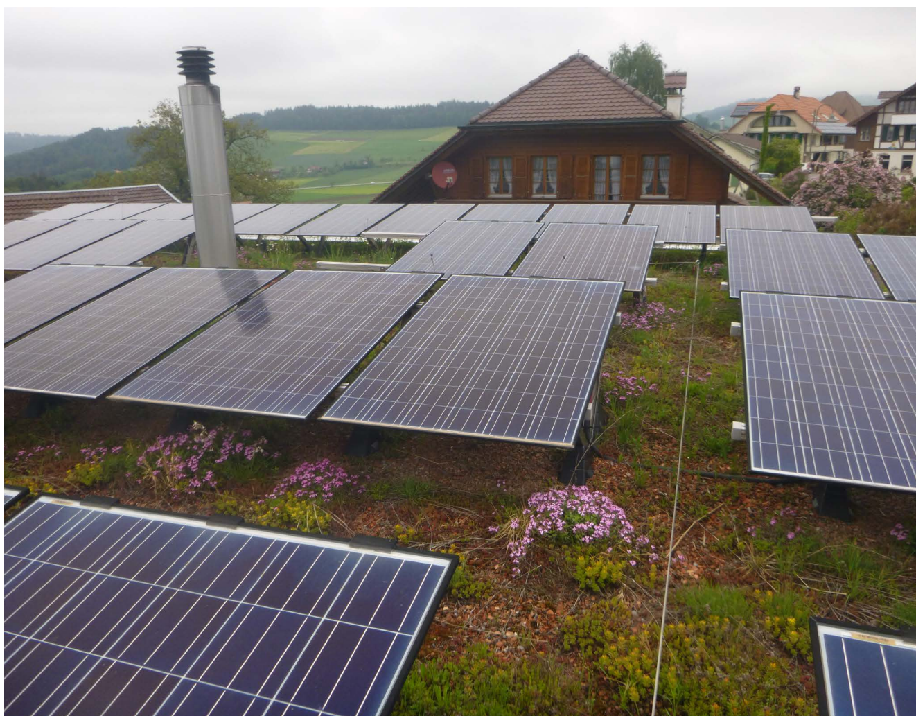
Figura 12: impianto fotovoltaico orientato a sud con substrato modellato di diverse altezze, fonte: Contec
