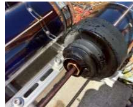
Abb. 2: Prüfen der Kollektor-Röhren von Innen
