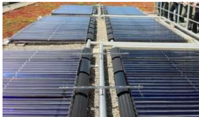
Abb. 1: Thermische Solaranlage flach auf dem Dach montiert
