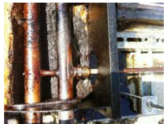
Abb. 3: Verschmutzung und zähflüssige Schicht im Innenrohr
