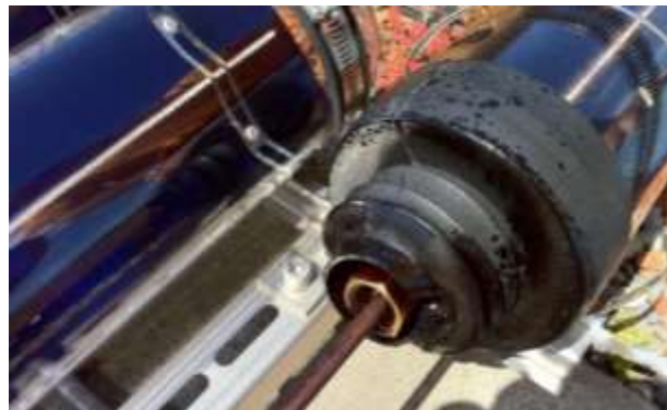
Abb. 2: Prüfen der Kollektor-Röhren von Innen
