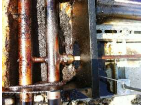
Abb. 3: Verschmutzung und zähflüssige Schicht im Innenrohr
