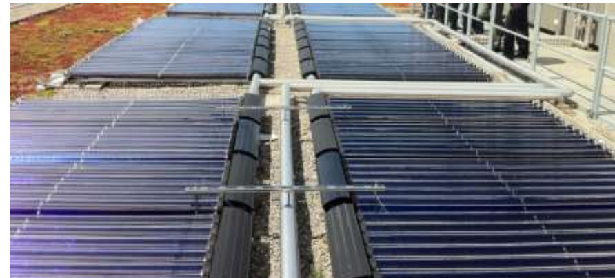
Abb. 1: Thermische Solaranlage flach auf dem Dach montiert
