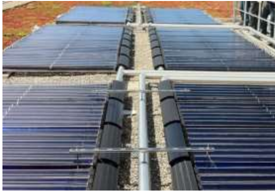
Abb. 1: Thermische Solaranlage flach auf dem Dach montiert
