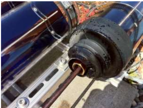
Abb. 2: Prüfen der Kollektor-Röhren von Innen
