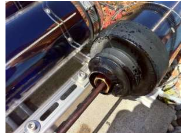
Abb. 2: Prüfen der Kollektor-Röhren von Innen
