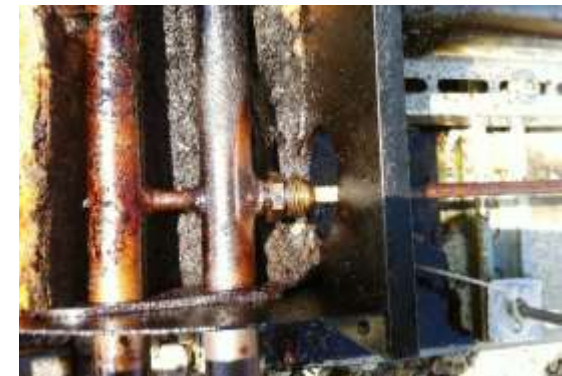
Abb. 3: Verschmutzung und zähflüssige Schicht im Innenrohr
