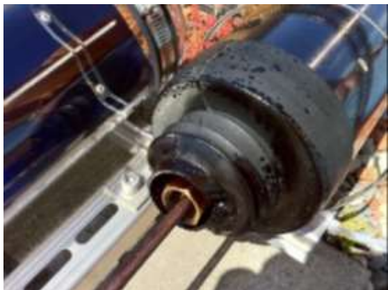
Abb. 2: Prüfen der Kollektor-Röhren von Innen
