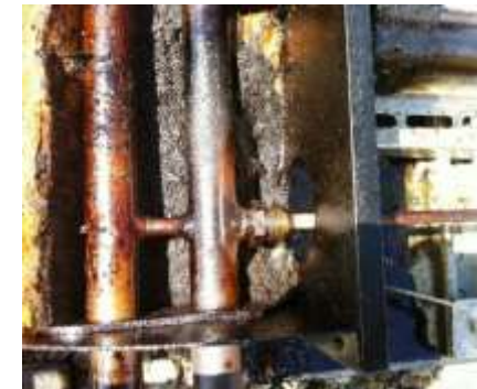
Abb. 3: Verschmutzung und zähflüssige Schicht im Innenrohr
