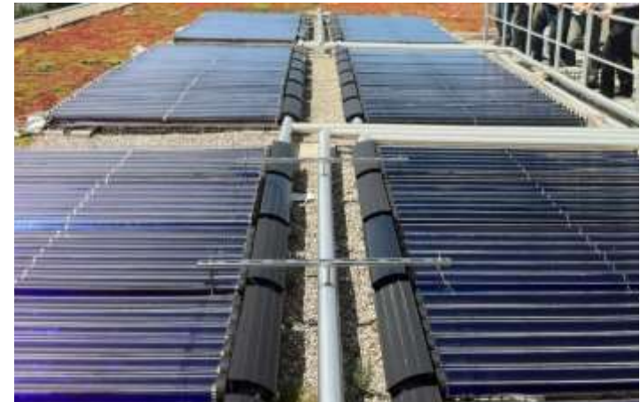
Abb. 1: Thermische Solaranlage flach auf dem Dach montiert
