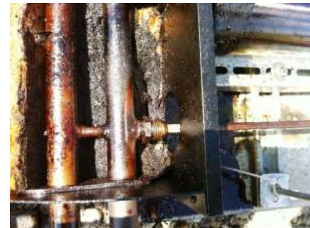
Abb. 3: Verschmutzungen und zähflüssige Schicht im Innenrohr
