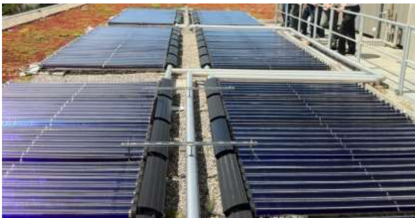
Abb. 1: Thermische Solaranlage flach auf dem Dach montiert
